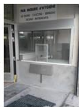
Mise en conformité de la station d'accueil
