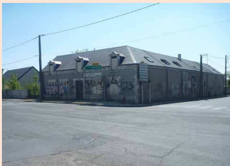
43-Ingré, séquence 1 (bourg-rue, n° 107) : intersection, construction d'angle historique (marqueur urbain et identitaire, projet immobilier à venir (porteur d'une déstructuration de la perception et de la volumétrie ?)
