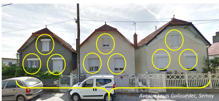
Composition harmonieuse de la façade
