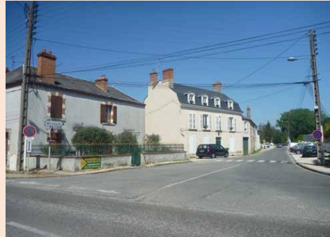
38-Ingré, séquence 1 (bourg-rue) : front bâti se retournant sur une rue sur peu de profondeur à l'endroit d'un point haut, maison bourgeoise (n° 1 rue du Grand-Puits) en R+1 présentant un toit à la Mansart, 18e siècle
