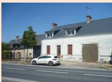
59-Ormes, séquence 1 (bourg-rue, numéros 94 et 96) : constructions en rez-de-chaussée légèrement de biais par rapport à la rue
