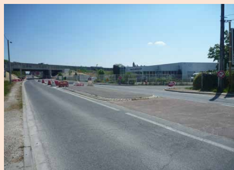
40-Ingré, séquence 1 (bourg-rue) : pont de l'autoroute (limite et point bas), ensemble industriel contemporain
