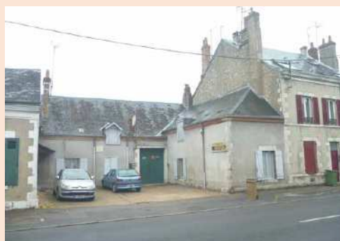
Rue du Faubourg-Bannier (n° 233 et 235) : construction sur cour à caractère agricole ou artisanal
