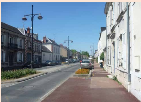
11-Saint-Jean de la Ruelle, séquence 1 (bourg-rue) : rue encadrée par des fronts bâtis en continu et pour l'essentiel en R+1, fin du 19e-début du 20e siècle
