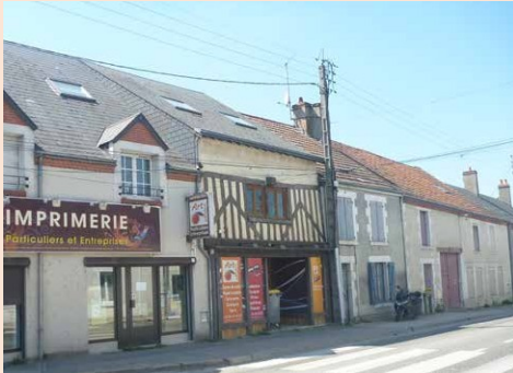
37-Ingré, séquence 1 (bourg-rue) : front bâti pourvu d'une façade (n° 55) à pan-de-bois à grille contreventé par des écharpes allant de sablière à poteaux, 18e siècle et antérieure
