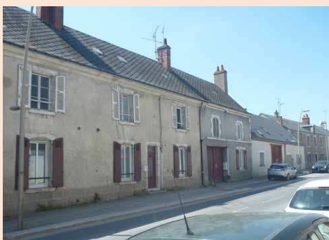
47-Ingré, séquence 1 (bourg-rue, n° 213) : front bâti en continu en R+1, rez-de-chaussée et à nouveau en R+1, constructions ouvertes sur la rue par des portes piétonne et des portails en bois, au premier plan construction du 18e siècle
