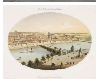
« Pont Royal, vue aval, Orléans, Loiret », France-Leroy, 1835
