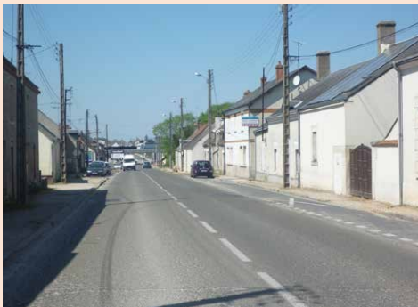
39-Ingré, séquence 1 (bourg-rue) : front bâti en continu présentant divers retraits et interruptions, à l'arrière plan le pont de l'autoroute (limite et point bas)
