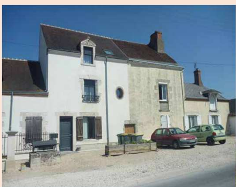
44-Ingré, séquence 1 (bourg-rue, n° 164) : construction du début du 16e siècle (marqueur mémoriel et identitaire)
