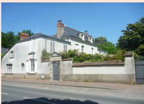
23-Saint-Jean de la Ruelle, séquence 2 (bourg-rue, n° 110) : maison bourgeoise (villégiature, 18e et 19e siècle), corps de bâtiment à la perpendiculaire de la rue, mur de clôture et vaste jardin
