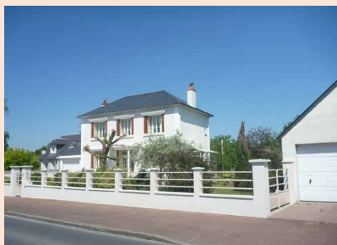
33-Saint-Jean de la Ruelle, séquence 2 (bourg-rue) : pavillon moderne en R+1 (typologie, 1950), modénatures en brique et en béton moulé, à l'arrière plan autre pavillon d'écriture plus récente
