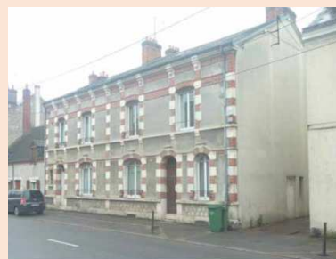
Rue du Faubourg-Bannier (n°199) : longère du 19 e siècle présentant des lucarnes engagées en bois à fronton triangulaire puis deux maisons de ville du 19 e siècle dont l'une pourvue d'un toit à la Mansart
