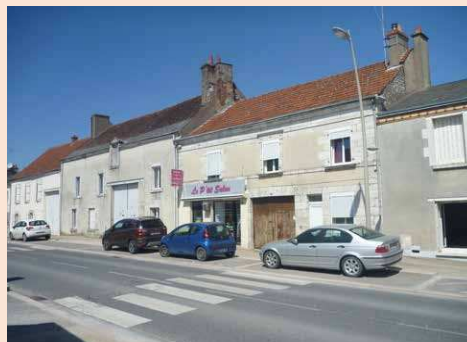
46-Ingré, séquence 1 (bourg-rue, numéros 210, 212, 214 et 216) : front bâti en continu en R+1, constructions ouvertes sur la rue par de vastes portails en bois, cours intérieures à usage agricole (ou artisanal), 19e siècle et antérieur
