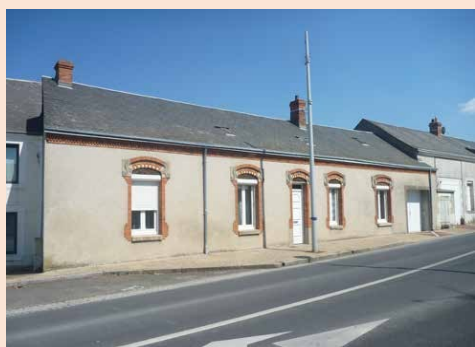
57-Ormes, séquence 1 (bourg-rue, n° 88) : construction en rez-de-chaussée légèrement de biais par rapport à la rue présentant des modénatures soignées en brique et en pierre Art nouveau, Belle Epoque
