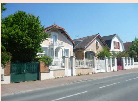
21-Saint-Jean de la Ruelle, séquence 2 (bourg-rue, nos 106, 104 et 102) : villas en R+1 en retrait de la rue et clôtures ouvertes (Belle époque et postérieur)
