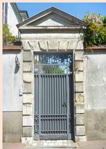
22-Saint-Jean de la Ruelle, séquence 2 (bourg-rue) : mur de clôture opaque (détail), jambages à bossage plat et fronton triangulaire (18e siècle)
