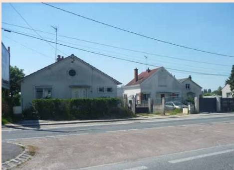
41-Ingré, séquence 2 (bourg-rue, numéros 93 et +) : ensemble de villas modernes plus ou moins en retrait de la rue
