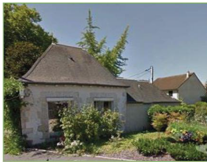
ANCIEN GRENIER À SEL
