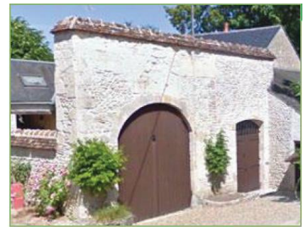
MUR AVEC PORCHE
