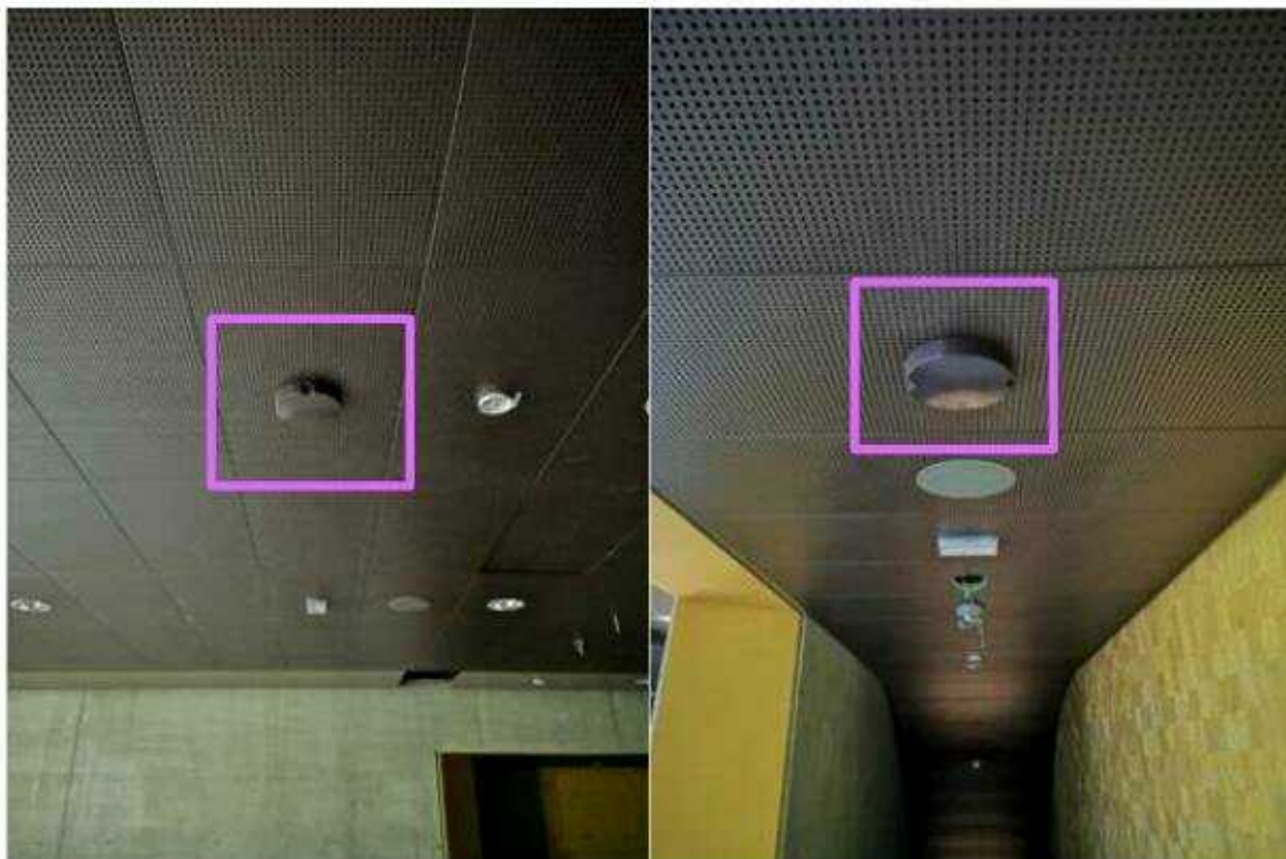
Figure 20 - antenne sur support faux plafond (Métro de Rennes Ligne b - Station St Jacques Gaité)
