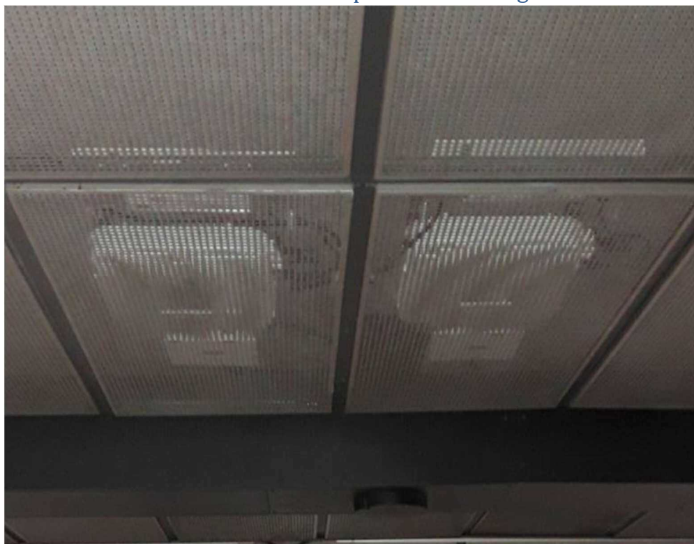
Installation Remotes dans le faux-plafond et câblage vers une antenne OMNI
