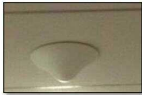
Figure 16 : Antenne sur faux plafond
