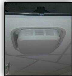
Figure 19 : Antenne sur support faux plafond
