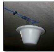
Figure 18 : Antenne sur plafond
