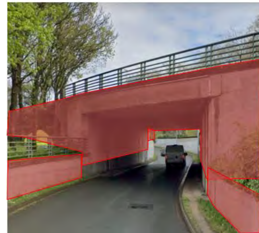
Figure 369 : Vue du pont de l'échangeur Joffre
