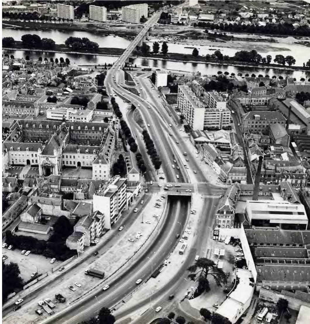
Figure 81 : Vue aérienne du boulevard Jean-Jaurès (à l'ouest du site), 1970
