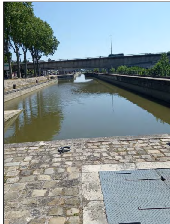
Figure 171 : Ecluse, en face du pont Thinat
