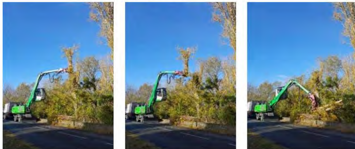
Démontage mécanique à l'aide d'une abatteuse.
