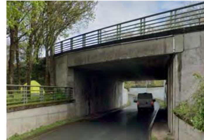
Vue du pont de l'échangeur Joffre
