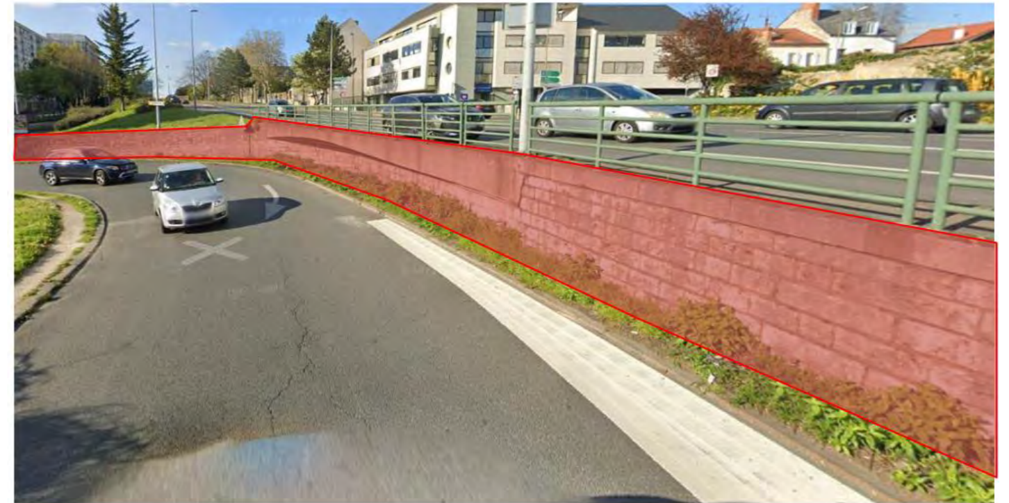
Figure 372 : Vue du mur maçonné Sud
