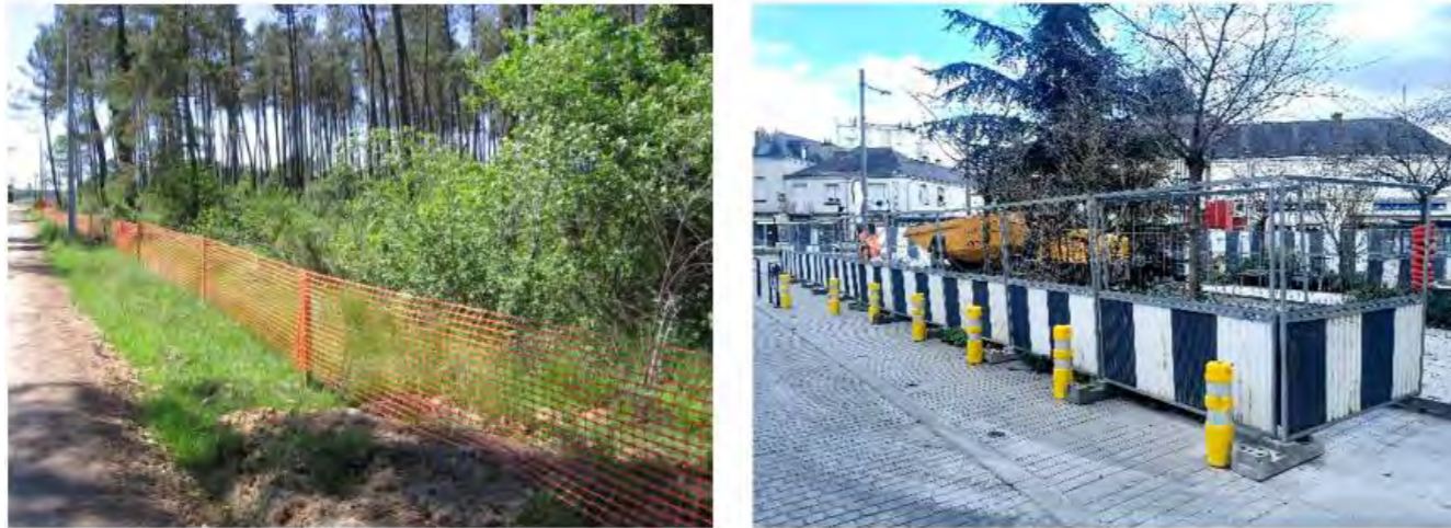
Mise en défens par balisage ou pose de clôture.
