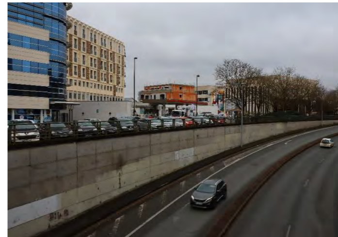
Vue de la partie Nord de la trémie de la RD2020 depuis le Pont Madeleine
