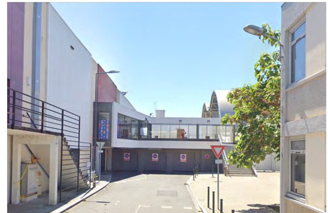
Photo 10 : La zone de projet depuis la Rue Saint-Yves, côté gare SNCF – 2021
