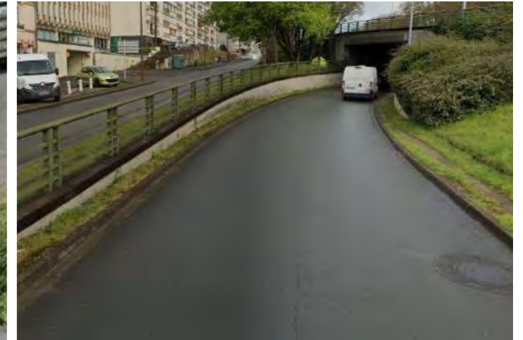
Vue des murs de soutènement Sud de la trémie
