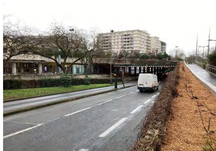
Vue des ouvrages routiers passant sous la dalle piétonne du centre commercial Place d'Arc
