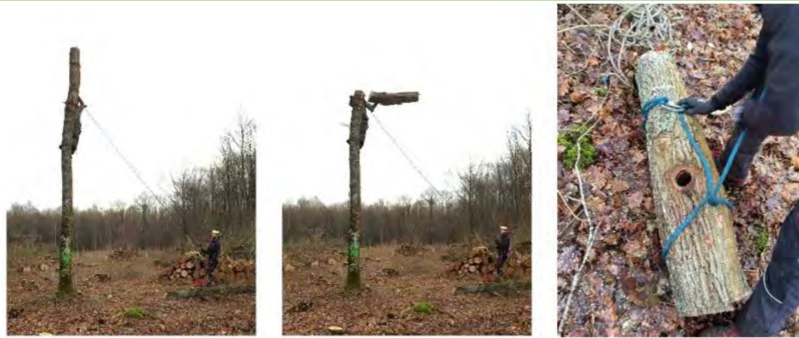
Démontage manuel assisté d'un arbre.
