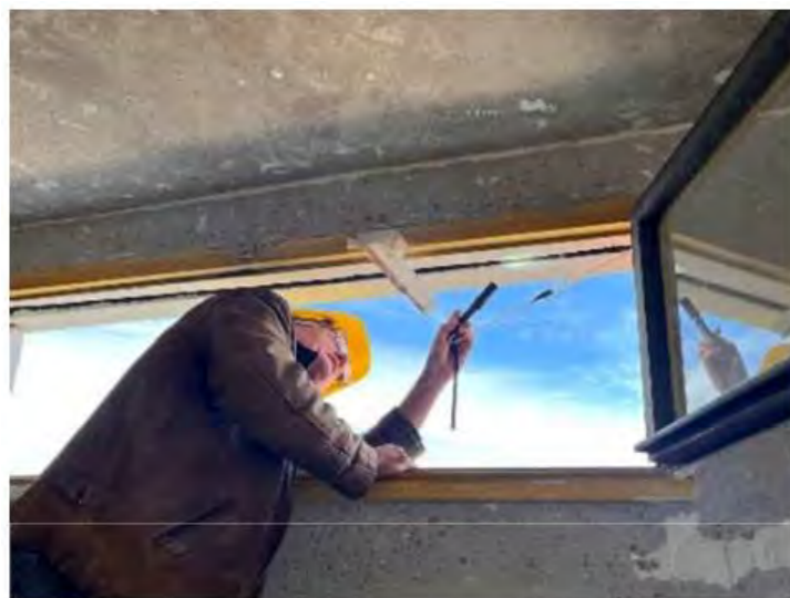
Inspection de cavité d'un bâtiment © Laurent Arthur.
