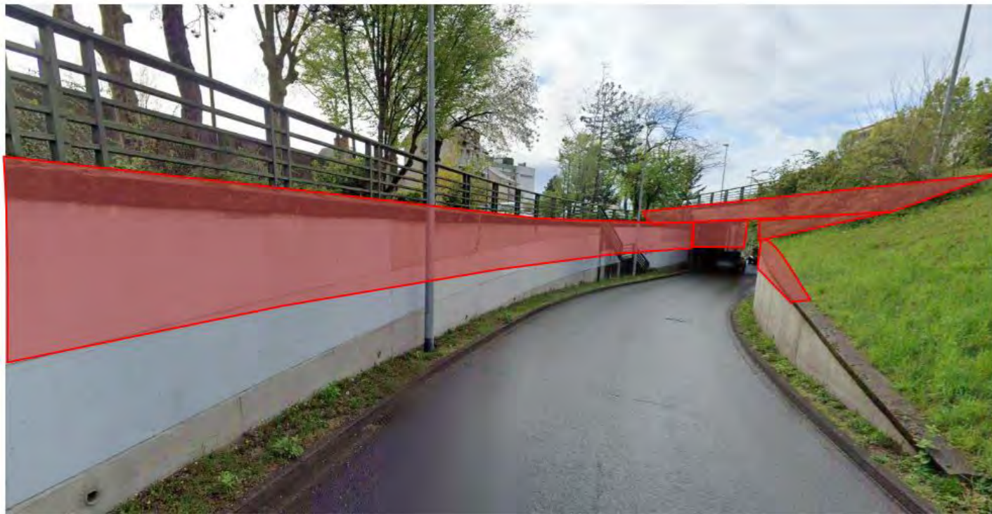
Figure 371 : Vue des murs de soutènement Nord
