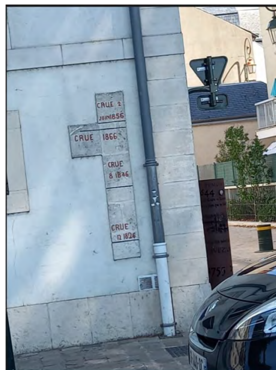
Figure 166 : Laisse de crue, rue des Bouchers (crue de 1826, 1846, 1866)
