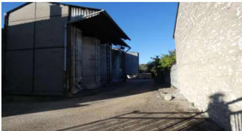
Anciens silos de vinaigriers – Source Commission d'enquête
