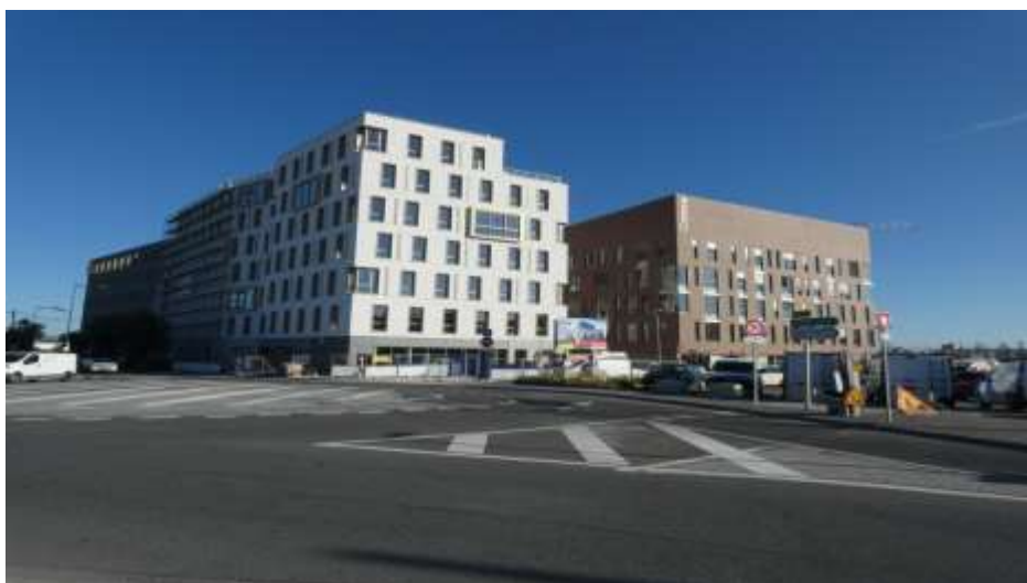
Aménagement en cours bordure RD 2020 (immeubles CCI et Orange avec R + 6 et 7) Source Commission d'enquête
