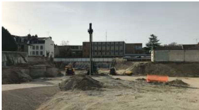
Ci-dessus travaux sur l'ancienne école de commerce
