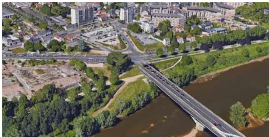
Le site de la Tête Nord du pont de l'Europe Source : Google Maps
