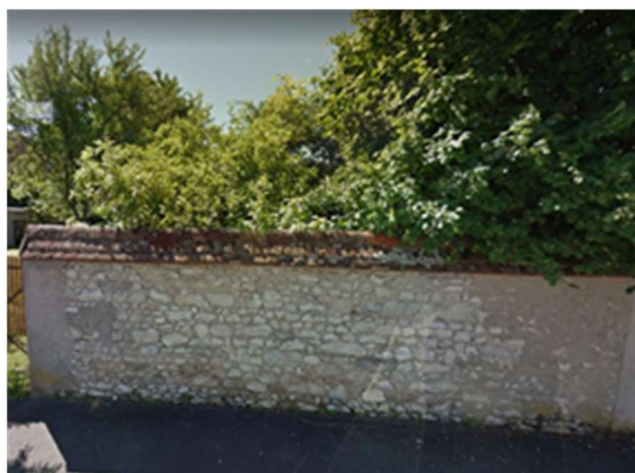
Mur en moellons
